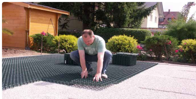
5.) Befüllen der Waben mit Rasenerde und Einsaat des Rasens.
